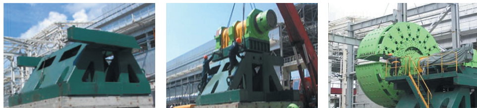
Рисунок 4. Последовательность монтажных работ мельницы самоизмельчения с размерами барабана D \times L = 5,0 \times 1,33 м
